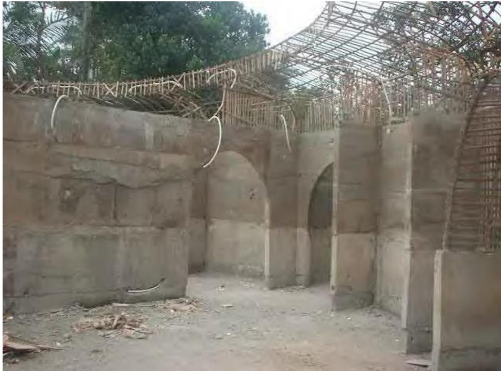
**Figura 17** - Ripas feitas de bambu com função de reforço para o concreto em Bali, Indonésia. Bauru – SP. 2010. **Fonte:** (PADOVAN, 2010).
