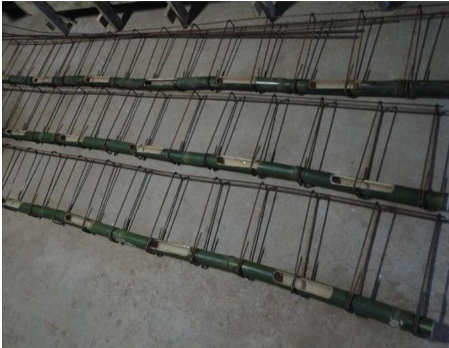
**Figura 20** - Vigas confeccionadas em bambu, contendo estribo feito em aço. Criciúma – SC. 2012.
