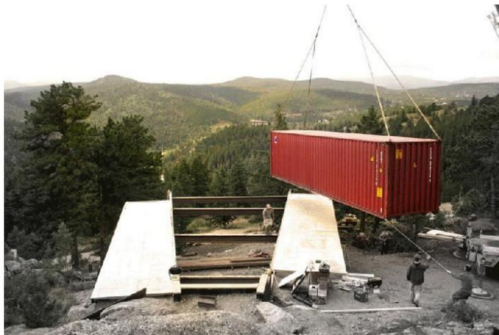
*Figura 61 - Fundação para o posicionamento do contêiner*
