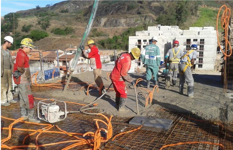
Figura 43 - Lançamento e vibração de concreto - Fonte: (ACERVO PESSOAL, 2017)
