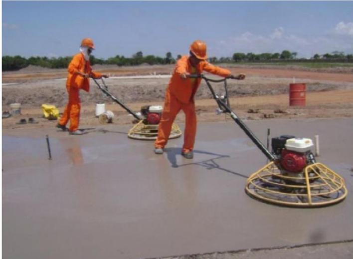
Figura 14 - Nivelamento da laje – bambolê - Fonte: (ACERVO PESSOAL, 2017)
