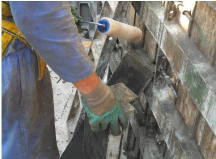
Figura 22 - Aplicação de desmoldante. Fonte: (ACERVO PESSOAL, 2017)
