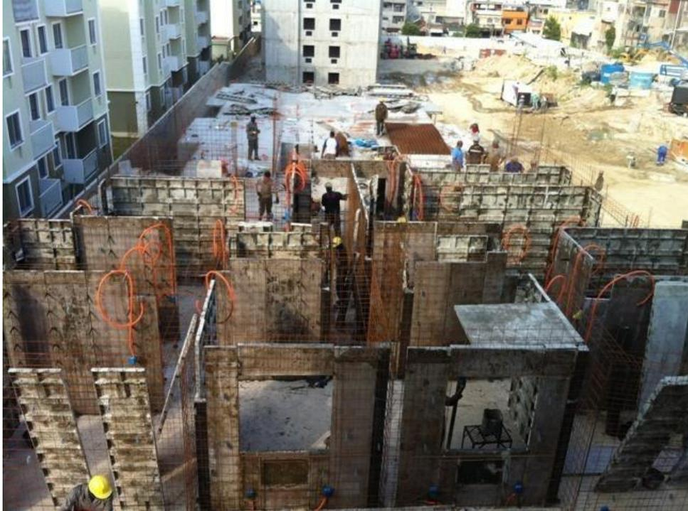
Figura 23 - Montagem de formas de parede - Fonte: (ACERVO PESSOAL, 2017)
