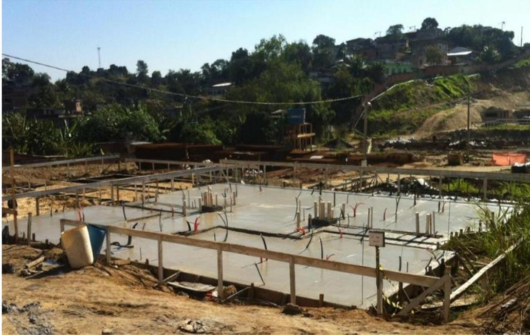
Figura 13 - Radier com instalações elétricas e hidráulicas - Fonte: (ACERVO PESSOAL, 2017)
