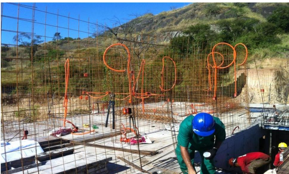
Figura 20 - Instalação de conduítes elétricos. Fonte: (ACERVO PESSOAL, 2017)
