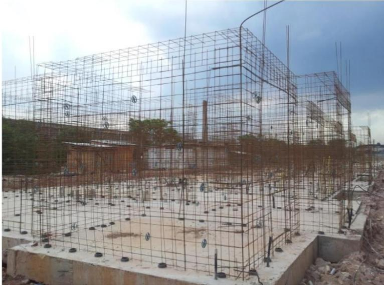
Figura 19 - Armação das paredes - Fonte: (ACERVO PESSOAL, 2017)
