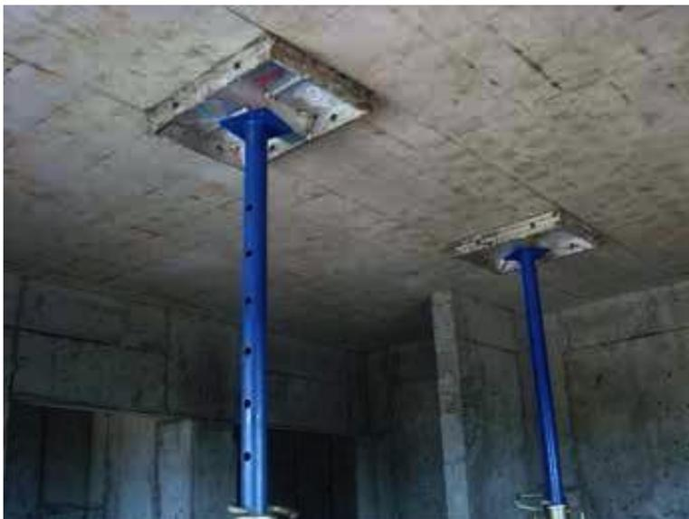
Figura 42 - Laje concretada com escoramento remanescente - Fonte: (CATÁLOGO FORSA)
