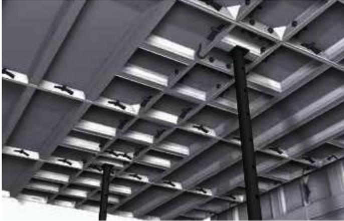
Figura 41 - Escoramento remanescente - Fonte: (CATÁLOGO FORSA)
