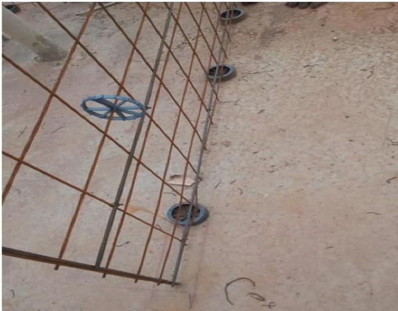
Figura 17 - Marcação com gabarito de parede - Fonte: (ACERVO PESSOAL, 2017)
