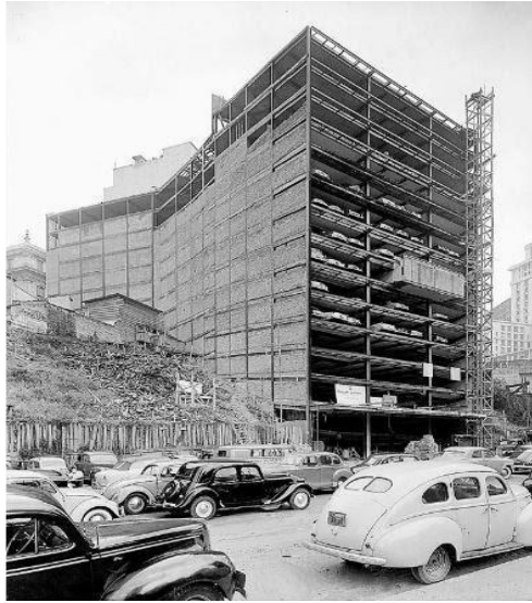
Figura 2: garagem América construída em 1954 Fonte: São Paulo city, 2020
