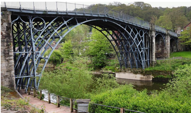
Figura 3 – Ponte sobre o Rio Severn. Fonte: COLIN, 2013.
