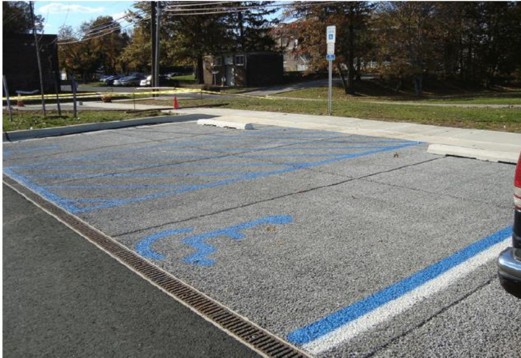
Figura 2- Concreto permeável executada a um estacionamento.
