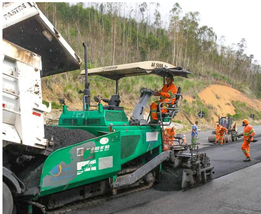
Figura 4: Vibroacabadora de Distribuição da Massa Asfáltica.
