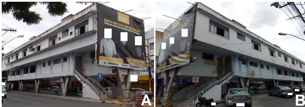
Figura 3A e 3B – Vistas panorâmicas do Terminal Rodoviário Roberto Silveira, Três Rios/RJ. Fonte: Os autores, 2021.
