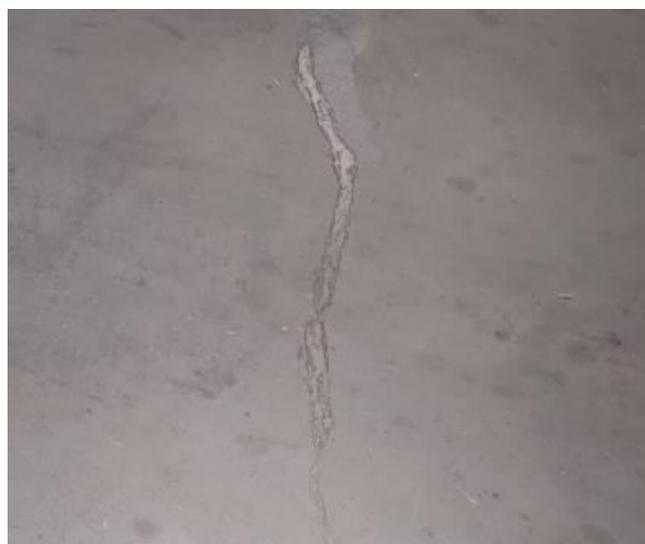
**Figura 4:** Manutenção corretiva – Adesivo Epóxi
