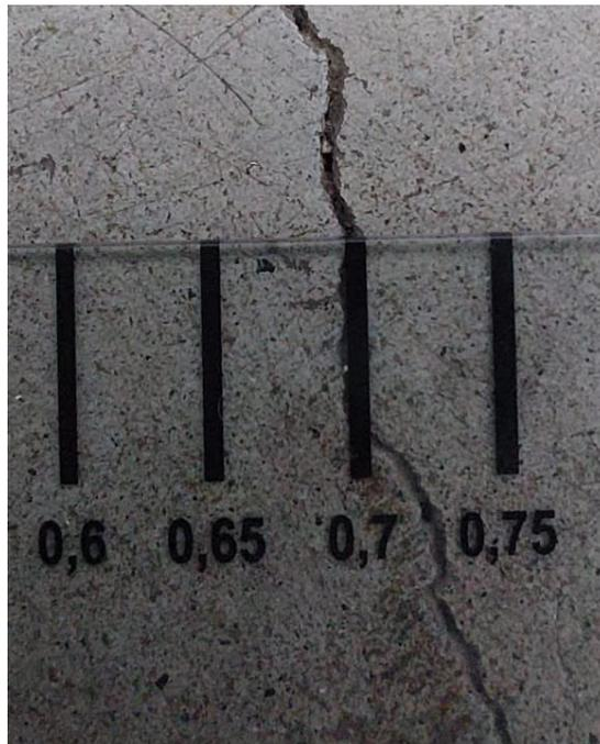
**Figura 2:** Patologia: Trinca – 0,7 mm
