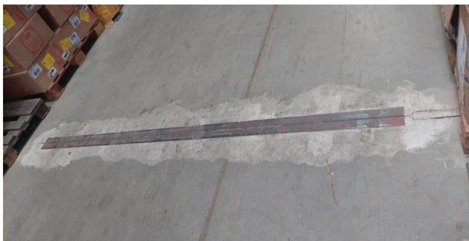
**Figura 5:** Manutenção corretiva – Placa de Aço
