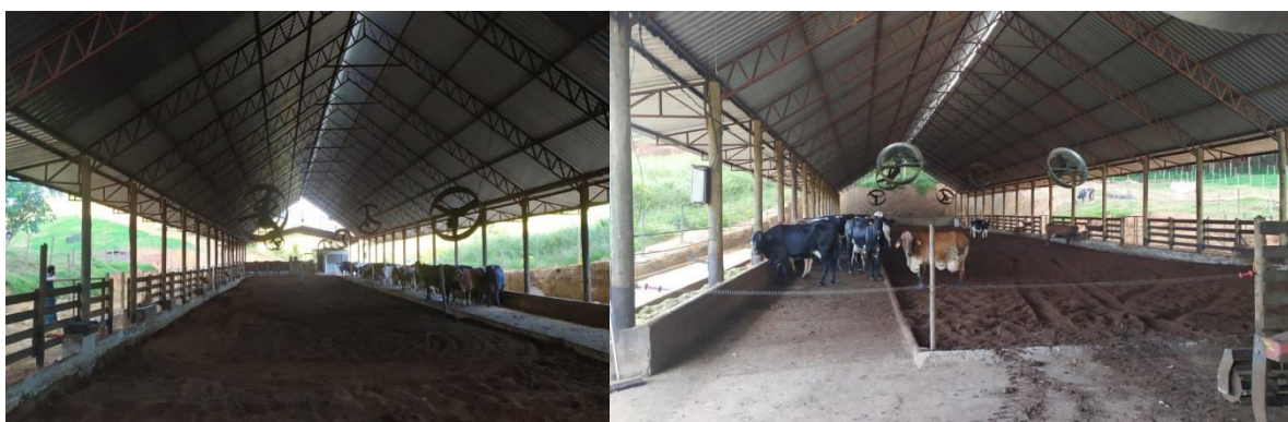
Figura 1: Instalações do Compost Barn – Fazenda Santa Rita, Raul Soares (MG).
