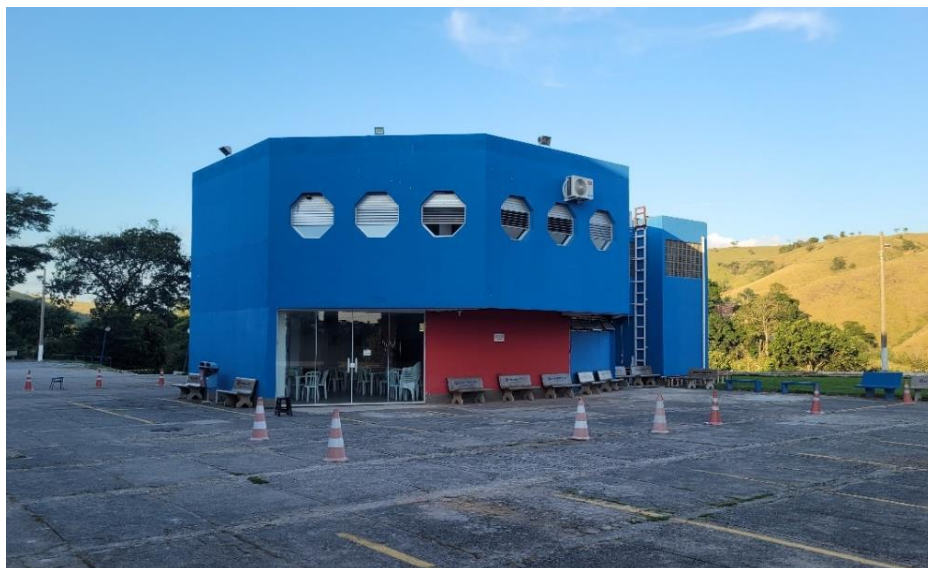
Foto: Vista da Cantina/Lancheonete (área de convivência)
